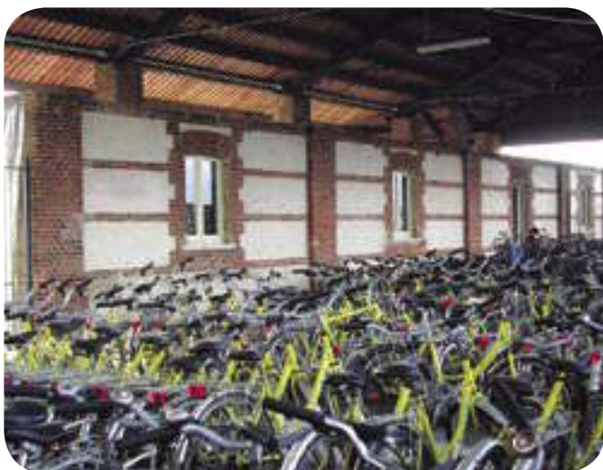
Foto: Cascina Prato Pascolo, tettoia ristrutturata per noleggio bici.
