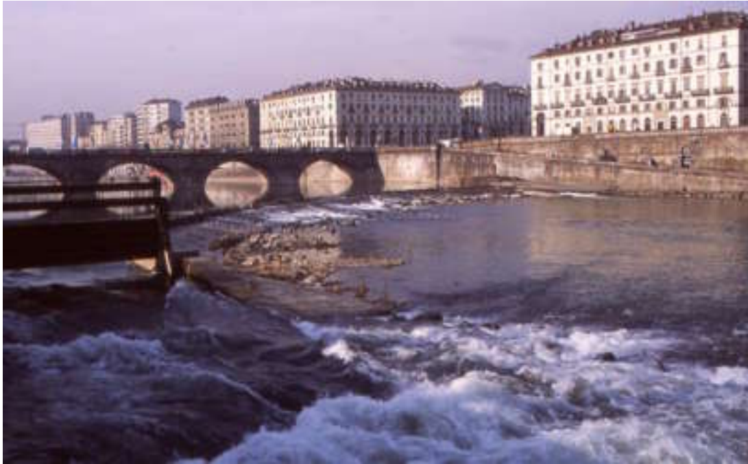
Fig. 13 - Il Po a Torino ai Murazzi. Si osservi la sponda cementificata e l'assenza di una fascia di vegetazione perifluviale in sponda idrografica sinistra
