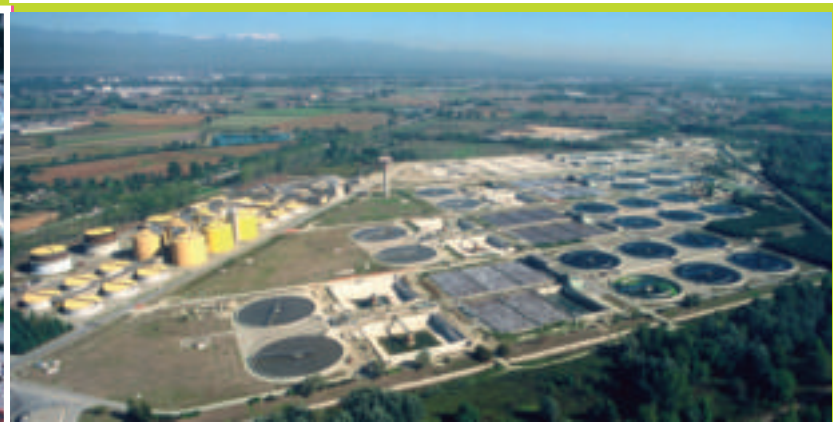
Impianto di depurazione di Castiglione Torinese
