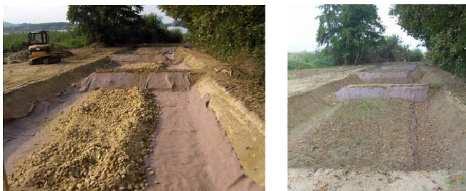
Figura 5 Dettaglio su primo modulo realizzato lungo canale di troppo pieno, sponda SE del Lago (sx: durante i lavori; dx: termine lavori)
